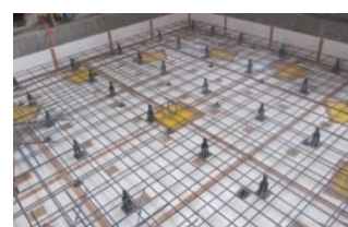
機械式駐車設備
