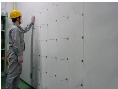
スピンドルピンの設置 壁面に接着剤で貼り付けます
