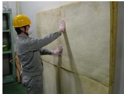
吸音材の設置 吸音皮膜が表になるように貼り付けます
